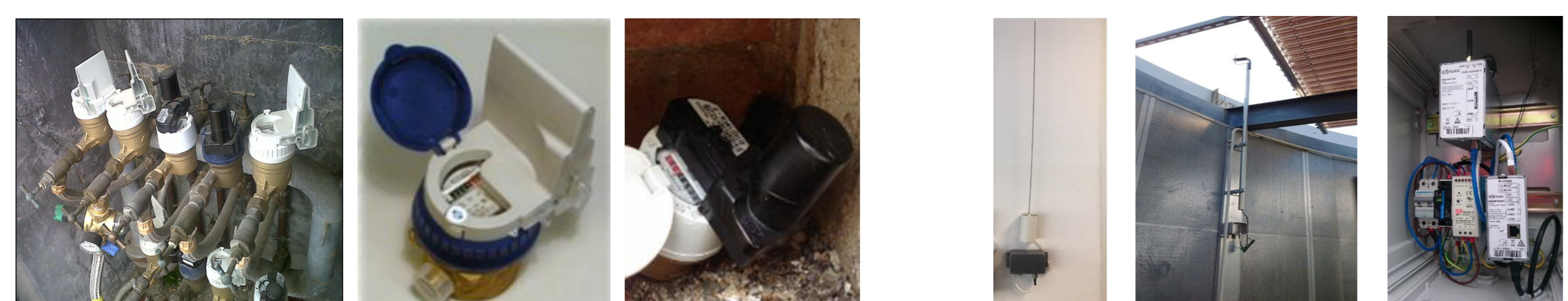
Contadores con módulo de emisión VHF 169 MHz
