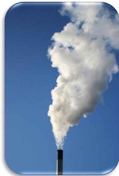
Figura 4.1: En una xemeneia els contaminants es dispersen segons un model Gaussià
